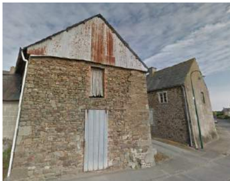
HABITATIONS DELABREES SITUEES RUE DE LA SOURCE
